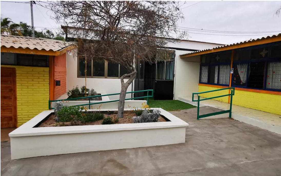
Vista a acceso sala multiuso en Escuela Ricardo Silva Arriagada
